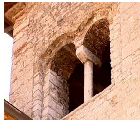
Chiesa San Pietro Apostolo: bifora del campanile
